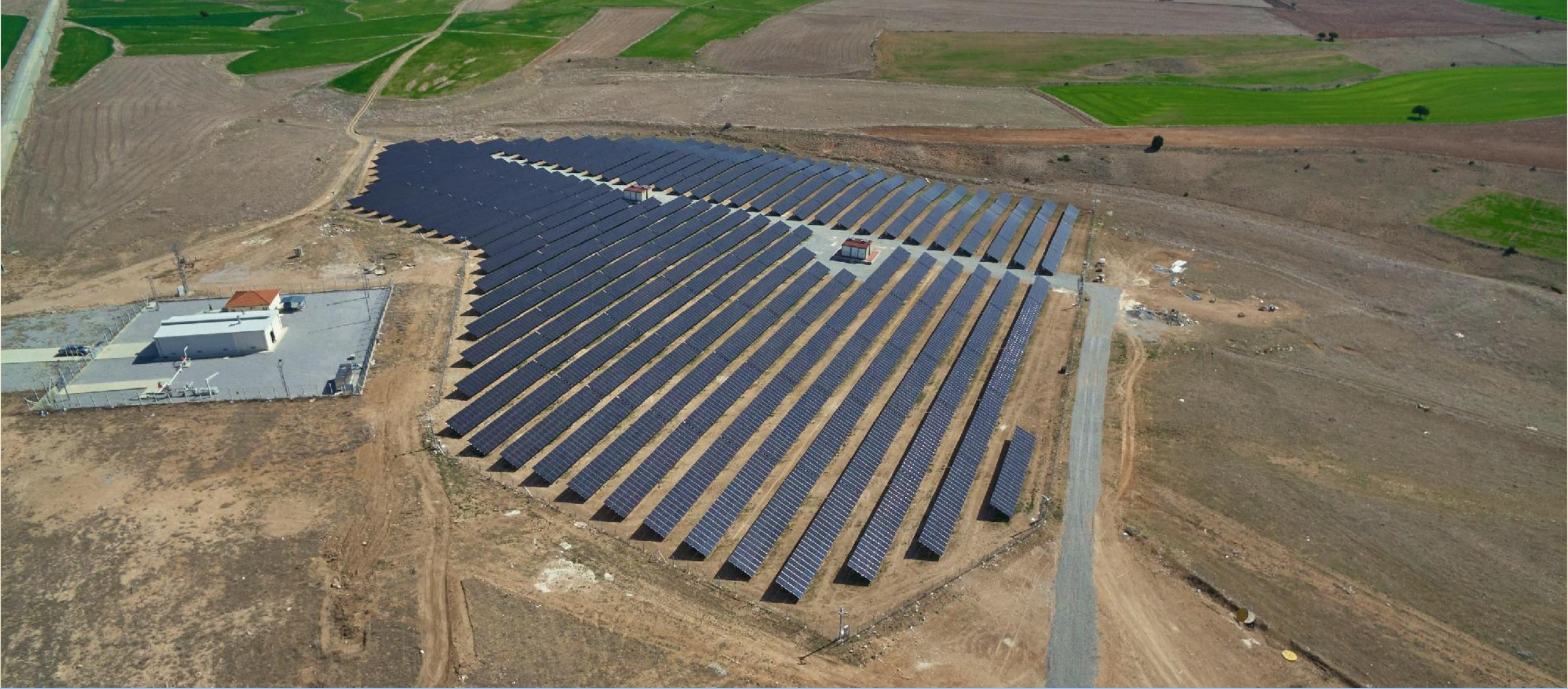
Güneş Enerji Santrali
